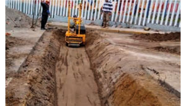
**Figura 33. Mitigación de grietas, apertura de la caja disipadora, relleno con material granular y bacheo para reanudar el tránsito vehicular y peatonal en la vialidad.**
