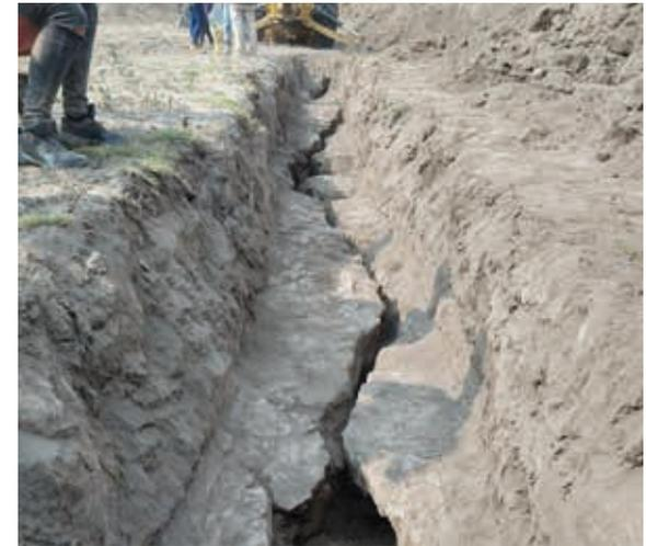
**Figura 39. Mitigación de grietas al interior de la UTOPIA Libertad, suelo fracturado (toba volcánica)**
