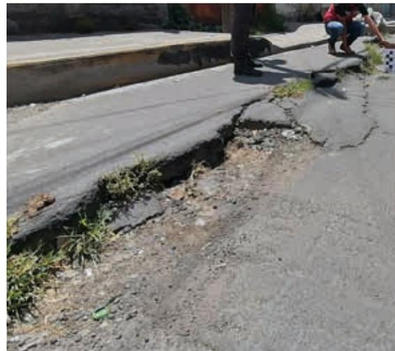
Figura 29. Grieta escala III ubicada en Avenida Texcoco esquina con Siervo de la Nación
